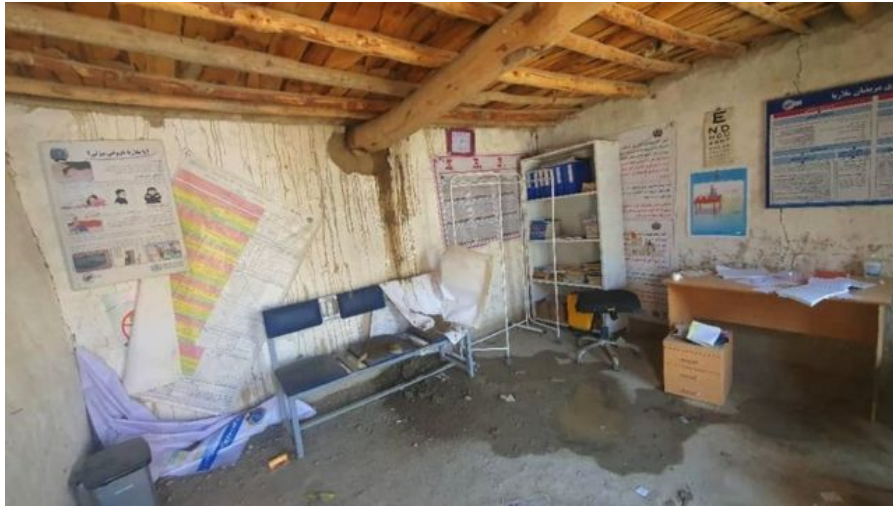
اتاق معاینه درمانگاه مرکزی ولسوالی "گیان" زلزله زده
